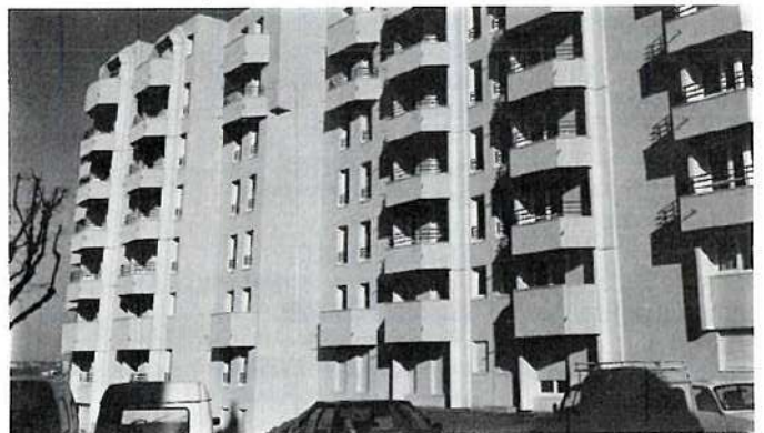
Immeuble financé par le 1 % à Issy-les-Moulineaux.
