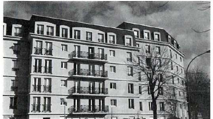
Immeuble financé par le 1 % à La Garenne-Colombes.
